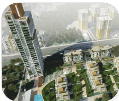
CNG LİVİN İZMİR – СТОЛЯРНАЯ ИЗОЛЯЦИЯ
